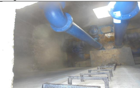
Descripción Registro Fotográfico: Entrada al Cuarto de Válvula
