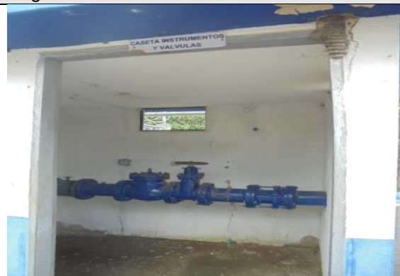
Descripción Registro Fotográfico: Instrumento – No está el Sensor de Presión
